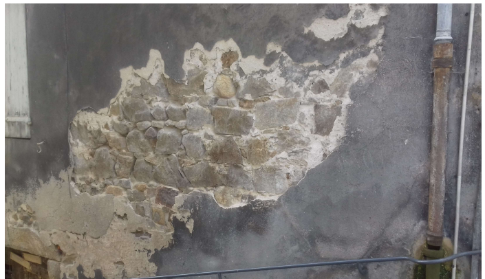
Enduit soufflé et joints friables (Photo 2019)
